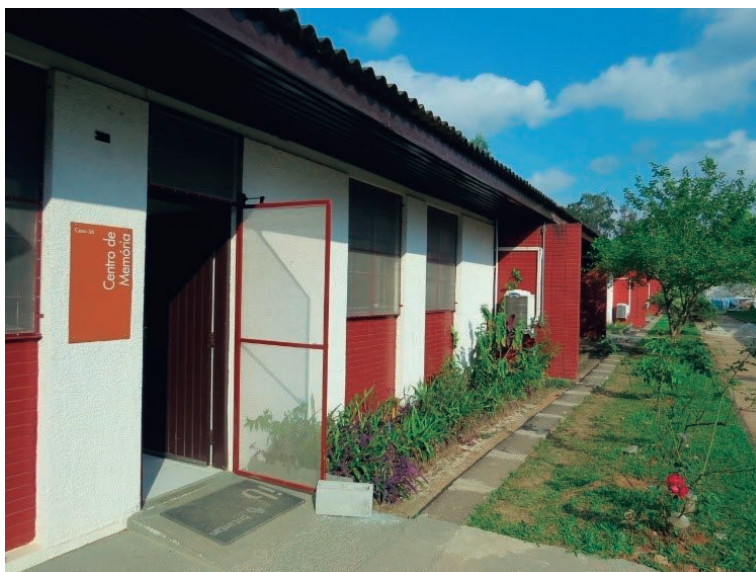
Fachada atual do Centro de Memória do Instituto Butantan, 2019. Foto do autor.
