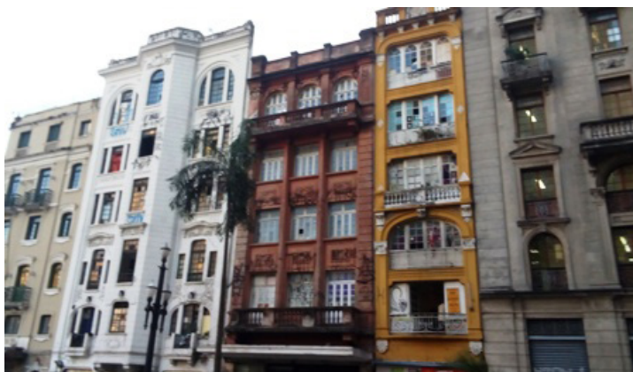
Figura 2: Conjunto de edifícios do lado par da Avenida São João
