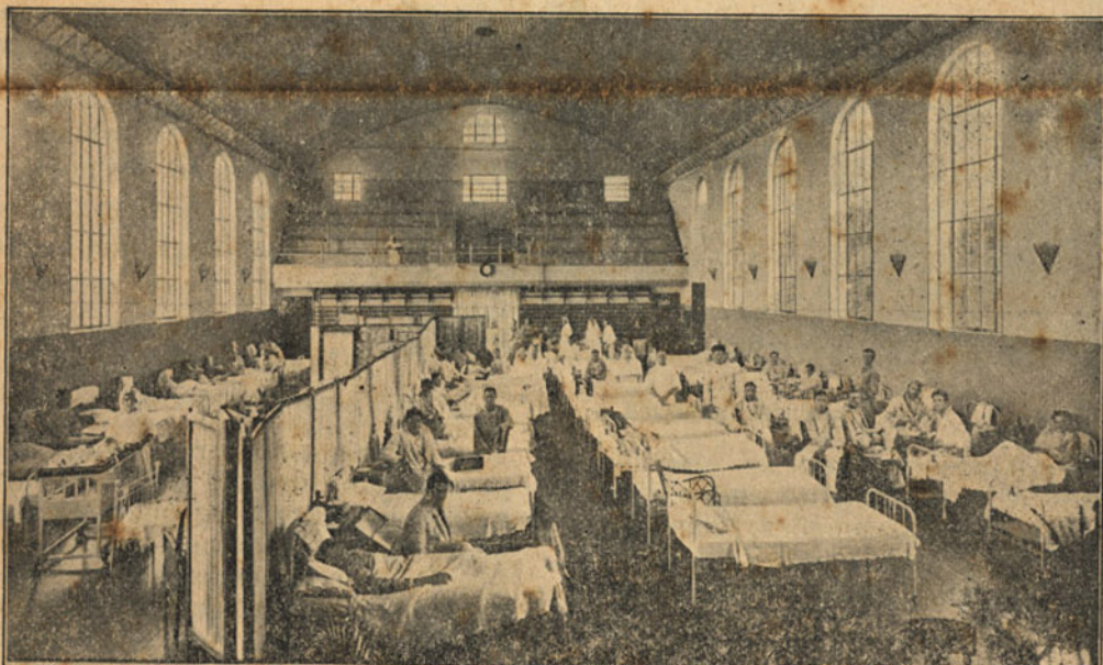
Hospital Mackenzie College, sob a fiscalização do Serviço Sanitario - VIII 1932
